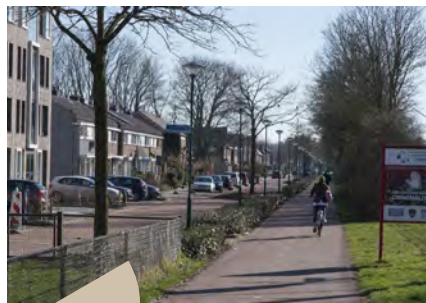
Vrijliggend fietspad langs Parallelweg
